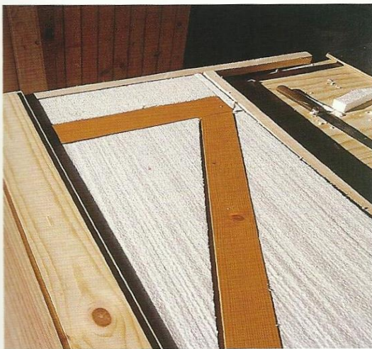
Habillez de lambris légers en recouvrement et décorez.
